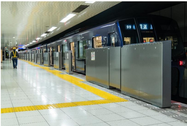
大和駅に設置したホームドア
