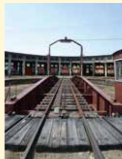
旧津山扇形機関車庫
