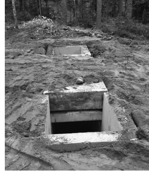
Kuva 7. U-elementeistä rakennettu taistelijaparin katettu tuliasema maanpäällisenä sekä maahan sijoitettuna.
