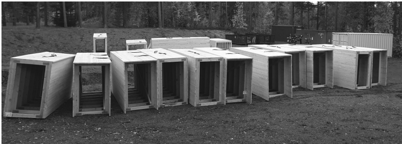
Kuva 3. Naulalevykehistä ja määrämittaisesta sahatavarasta tehtyjä kevyt-ositalaelementtejä.
