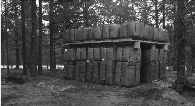
Kuva 2. Suurhiekkäsäkeistä tehty maanpäällinen katettu linnoite.
