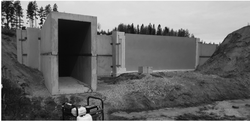
Kuva 8. Komentopaikkalinnoitetta rakennetaan betonielementeistä.
