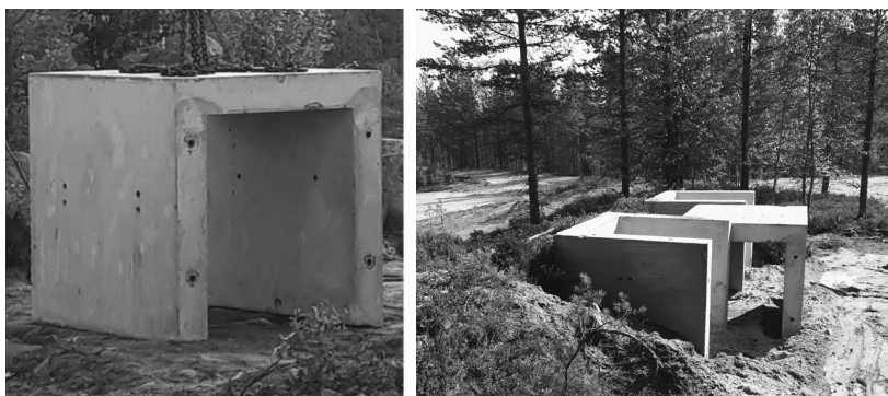
Kuva 6. Betoni U-elementti (1400 x 1400 x 1400 x 200 mm) ja elementeistä rakennettu maanpäällinen taistelijaparin tuliasema.
