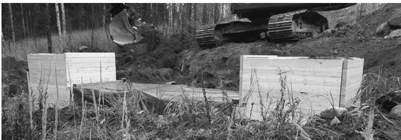
Kuva 4. Kevytositalaelementeistä rakennettava taistelijaparin katettu tuli-aseama.
