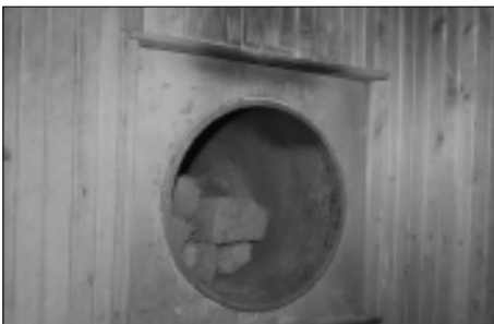
Saunan kiukaana toimi 200 litran tynnyri (Kuva: Kalervo Sipi)
