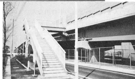
▲4ヶ所に設置された歩道橋
