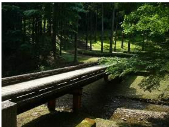
アシダ曲輪下の木橋
