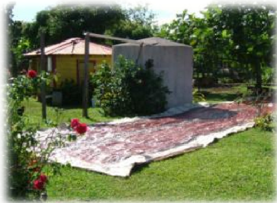
←各家庭にある 雨水タンク
