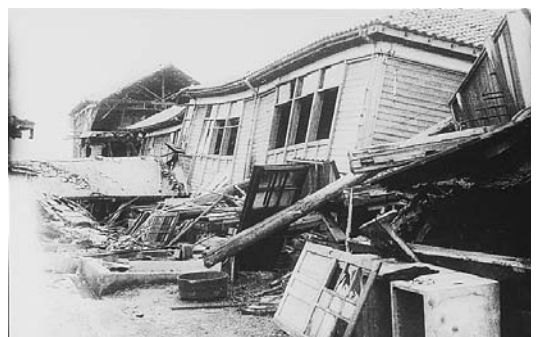
部分的に倒壊した木造小学校校舎（坂井郡）。小林啓美氏撮影・提供。
