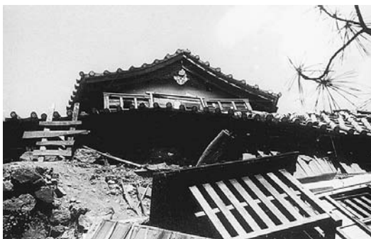
石垣が崩れたために潰れた当時の国宝・丸岡城天守閣（坂井郡丸岡町）。後年再建され、現在は重要文化財。小林啓美氏撮影・提供。
