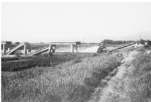
橋桁が落下した国道中角橋(九頭竜川)。小林啓美氏撮影・提供。
