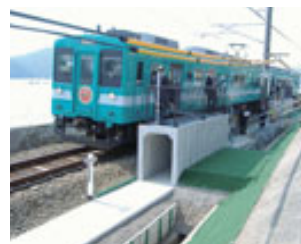
列車から避難するために駅間に設置した避難誘導降車台
