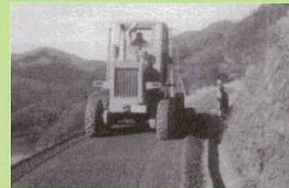
大幹線林道天竜川線 (中井侍地籍)
