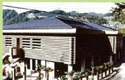
なんでも館竣工
