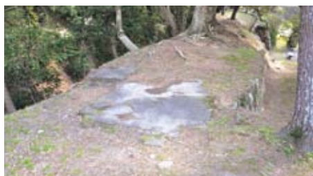
貯水槽(今橋町 豊橋公園)
