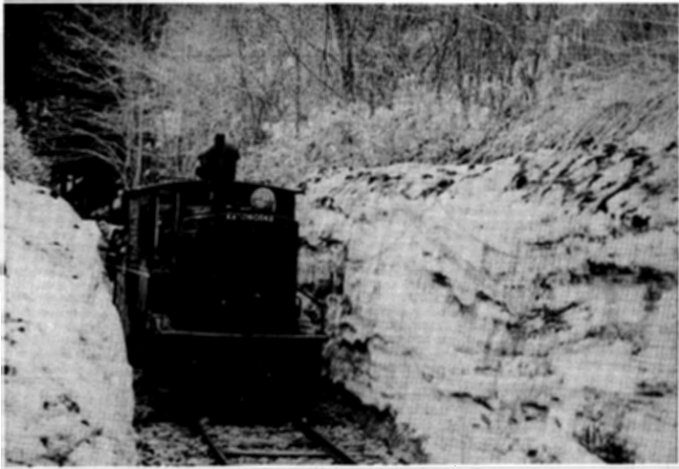
物資、資材等の運搬につかわれた軌道車
