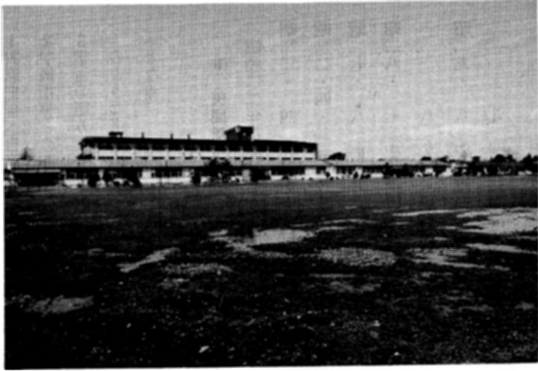
天間館中学校々舎
