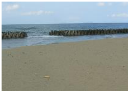
離岸堤群建設 昭和 41 年頃～
