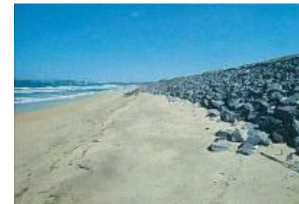
石積護岸建設 平成 11 年頃～
