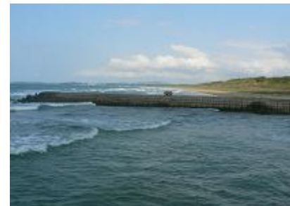
導流堤建設 昭和 36 年頃～
