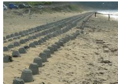
消波ブロック護岸建設 昭和 58 年頃～
