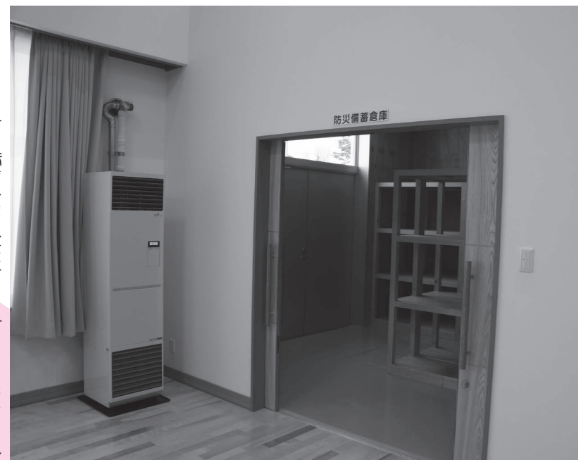
防災備蓄倉庫（大江コミュニティセンター）
