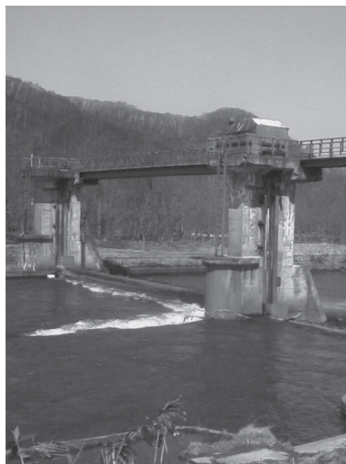
頭首工改修整備事業
