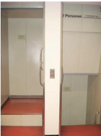
ドイツ特許商標庁内のエレベーターの写真です。このエレベーターには扉がなく、常に動き続けています。一方の側は常に上りで、他方が下りです。乗る時にも動き続けているので、急いで飛び乗る必要があります。
