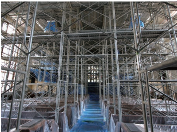
礼拝堂修復（内部）
