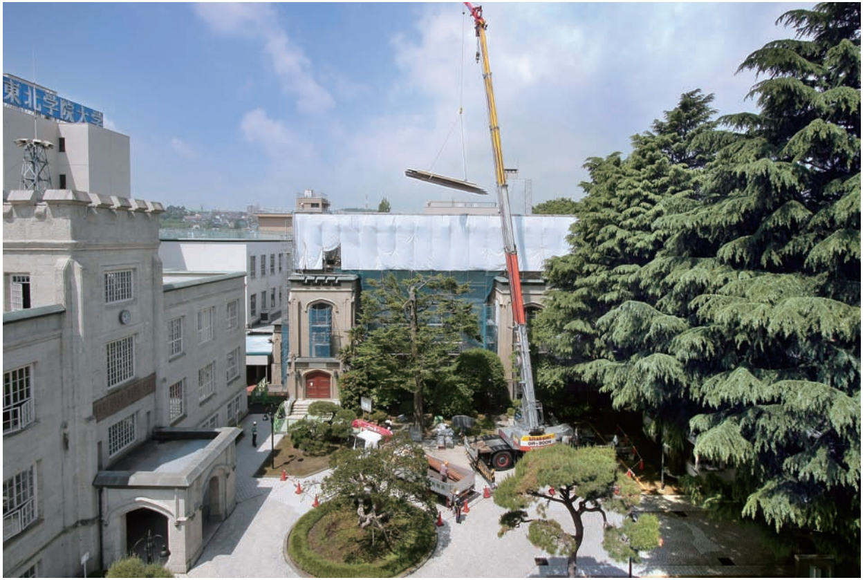
礼拝堂修復（外観）
