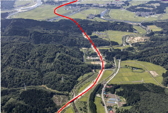
起点側から終点側を望む
