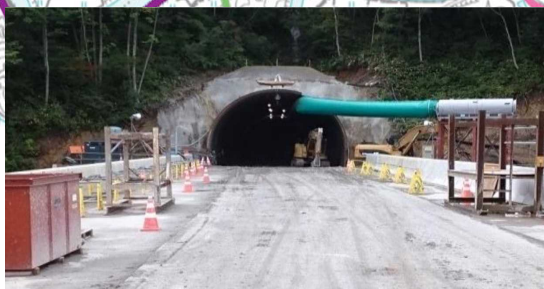
② ぜんなみ 前波トンネル
