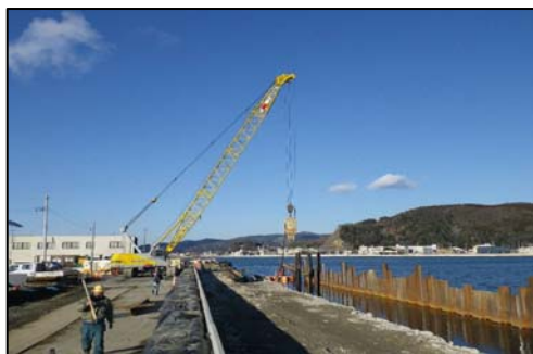
旧北上川河口部右岸築堤工事 (矢板護岸)工事状況
