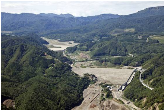
試験湛水前の胆沢ダム(平成24年10月撮影)
