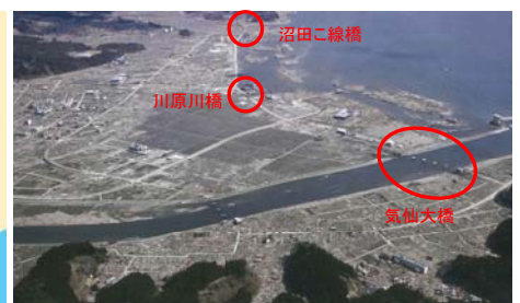
▲陸前高田市内の被災状況
