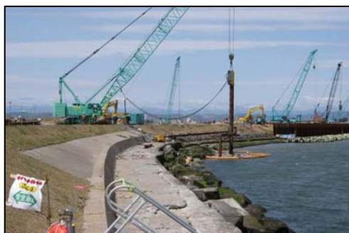
名取川河口部右岸築堤工事 (縮切矢板)工事状況
