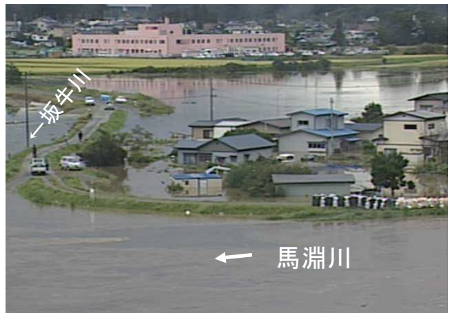
▲八幡地区の家屋浸水状況
