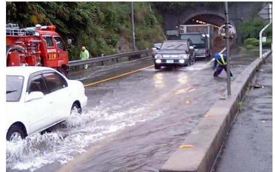
▲一般国道6号越波の状況
