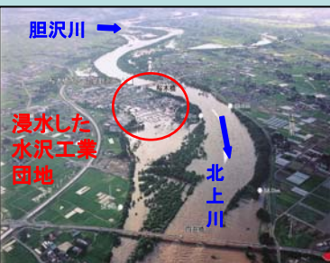
平成14年7月 出水状況 (胆沢川合流点付近)
