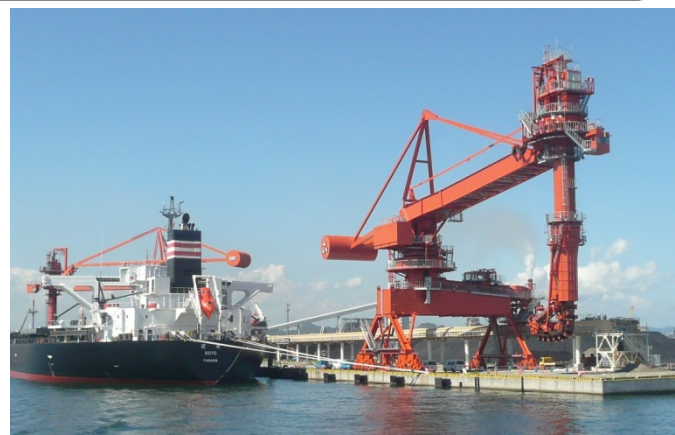
▲石炭運搬船による荷役状況
