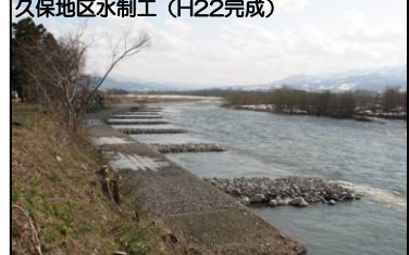
■河川の多様な流れの形成(水制設置)
