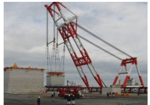
▲防波堤本体製作状況 [防波堤(沖)]
