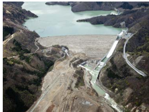
試験湛水状況(平成25年5月7日撮影)
