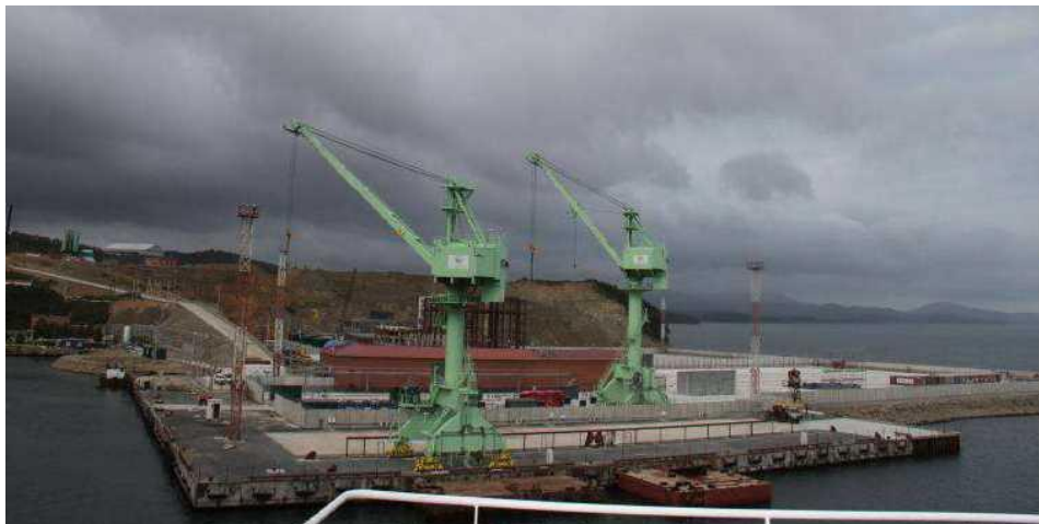
図3 原子炉区画長期保管施設の全容
