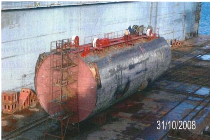
図1 浮きドック FD-90 上で形成され、仮置きされた 3 原子炉区画ユニット（北東地域修理センター）
