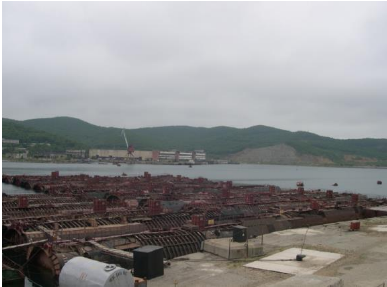
図2 ラズポイニク湾での3原子炉区画ユニットの海上保管状況
