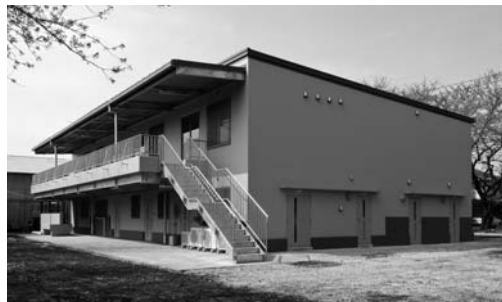
新しいクラブハウス外観(20.3.31 竣工)
