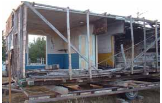
(81). Fotografía de la Casa Stirling desmontada durante la preparación de su traslado hasta Puerto Williams. Bahía Douglas, 2004 Dismantled Stirling House during preparations for its move to Puerto Williams, Douglas Bay, 2004
