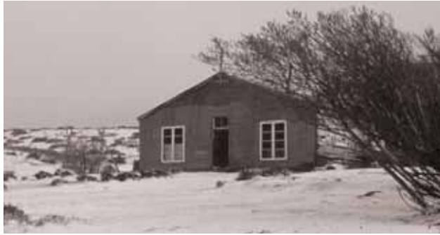
(74). Fotografía de la Casa Stirling en Bahía Douglas en la década de 1990 Stirling House on Douglas Bay
