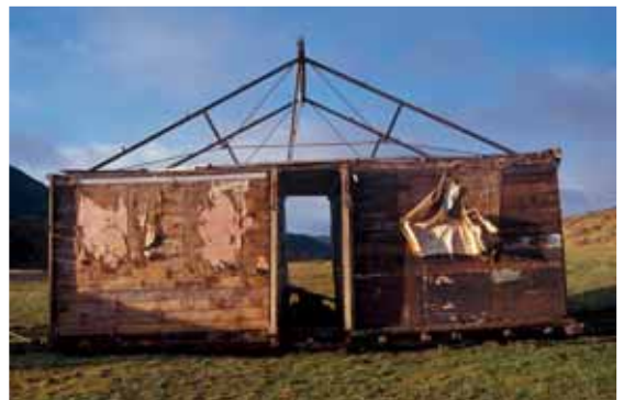
(82). Fotografía de la reinstalación de la Casa Stirling en Puerto Williams tras su traslado durante el año 2004 Reconstruction of the Stirling House in Puerto Williams after its move in 2004
