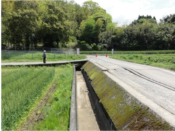
Fu1: 嘉島町井寺付近（地表変位の西端）約 10cm の右ずれ
