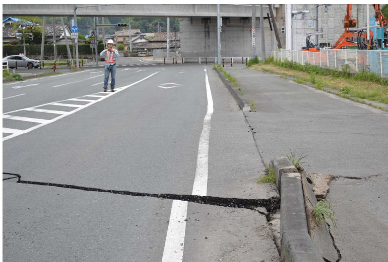
地点1（土山） 右横ずれ 20-30 cm 14日の地震後に多少の変位があった。目立った段差になったのは、16日未明のM7.3の地震後。
