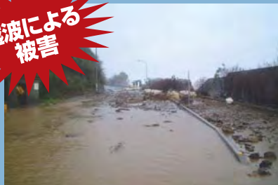
平成16年8月30日の台風16号の際には、越波による浸水・靄石で約5時間にわたり通行止め
