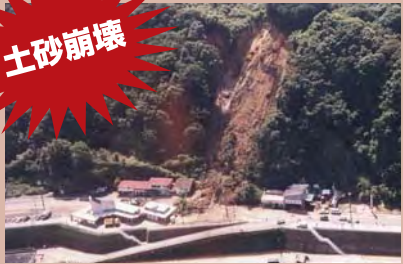
平成10年5月の土砂崩壊では約57時間にわたり通行止め
