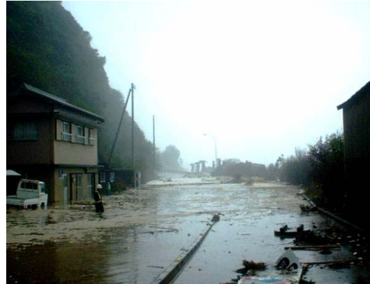
▲ 台風の越波により冠水し通行止めとなった高知県安芸市大山岬付近の国道55号（平成16年8月）
