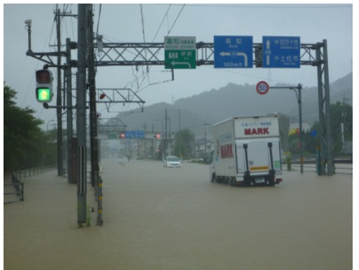
▼H26.8 台風12号 路面冠水状況【写真③】
