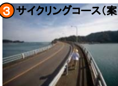
3 サイクリングコース(案) 横浪黒潮ラインに続く (主)47号線宇佐大橋
