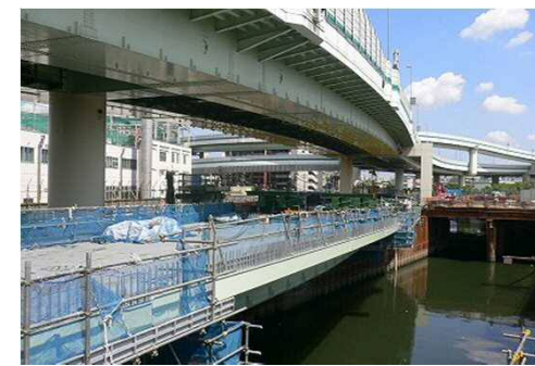
写真③ 入口部上部桁架設工(完了)
