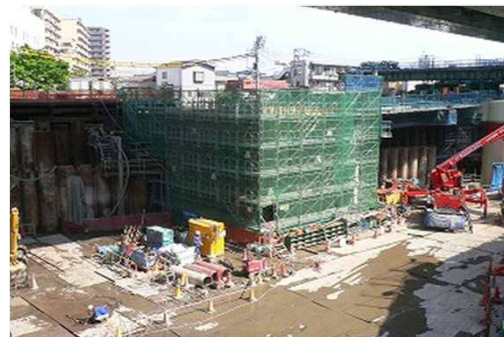
写真② 橋台構築工
