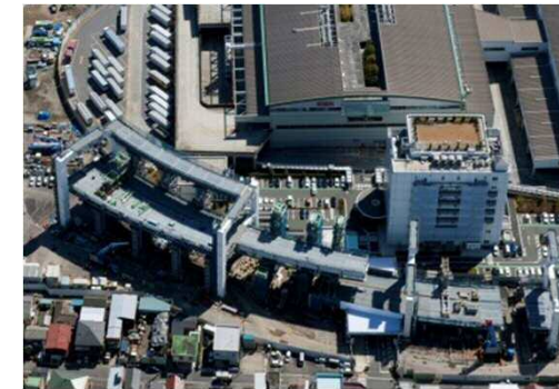
写真④ 生麦JCT (上部桁架設工)
