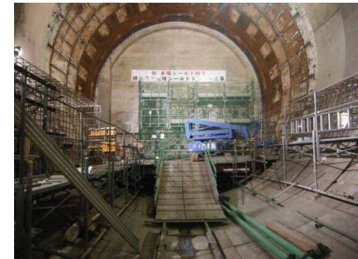
写真③ シールド到達状況
