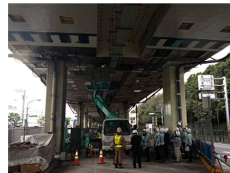
橋梁の維持管理技術に関する勉強会 (1号羽田線勝島地区)
