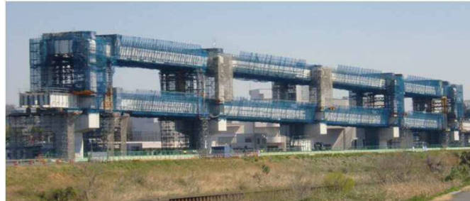
写真② 鶴見川並行部 (上部桁架設工)
