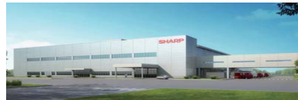
2012年4月に稼働したSOCC第2工場
