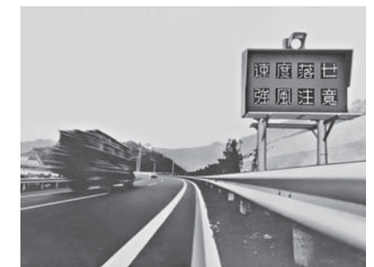
東名高速道路に設置された、世界初の道路気象情報システム(自動的に警報を出す電光表示板)(1969年)
