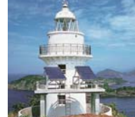
当時、世界最大の出力225Wの太陽電池を設置した御神島灯台(写真提供海上保安庁)
