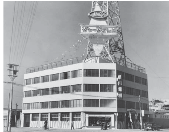
福岡市長浜町(現・福岡市中央区長浜)に竣工した福岡支店(1958年)
