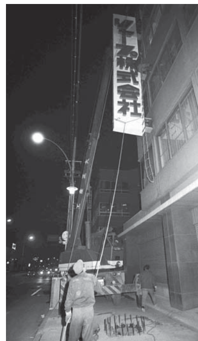
社名変更に伴う、本社での社名看板の取り換え作業
