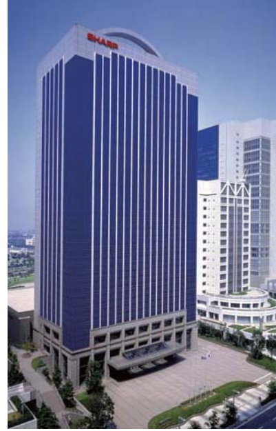
東京支社〈幕張ビル〉〈千葉県美浜区〉
