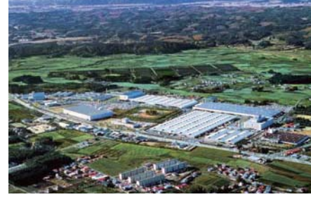
栃木事業所〈栃木県矢板市〉
