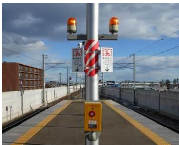
〈列車非常停止警報装置〉
