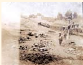
▲工事の様子(大正10年頃)
