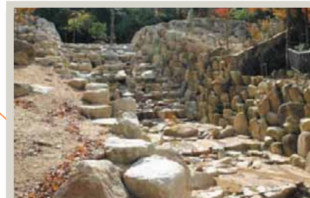
宮島で最も歴史が古い大聖院との景観に配慮して施工した2号えん堤
