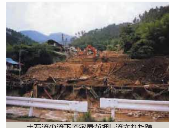
土石流の流下で家屋が押し流された跡 H11.6 堂ヶ原川支川 広島市佐伯区
