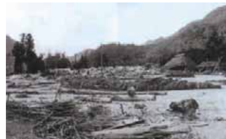
◀岩淵谷川(広島市佐伯区)で発生した土石流
