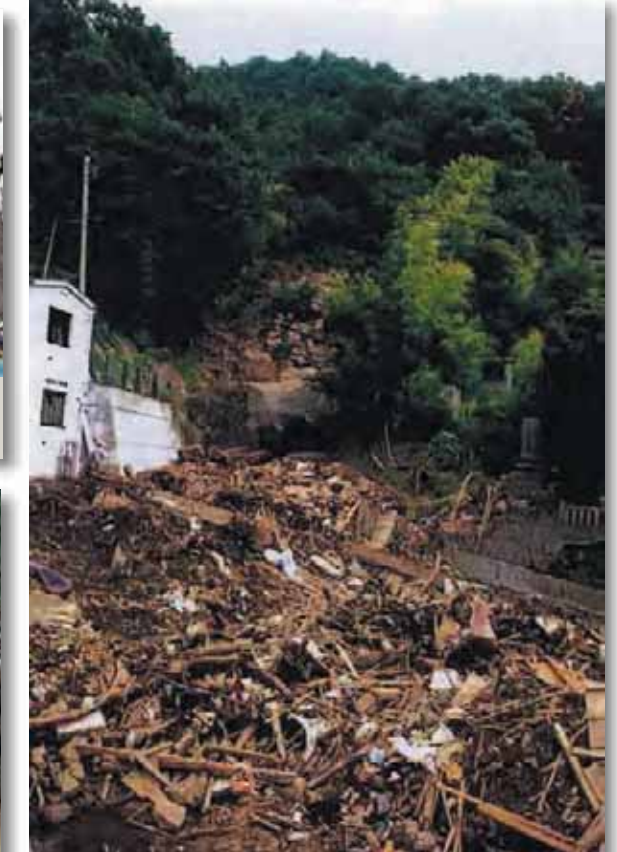
がけ崩れにより家屋が倒壊した跡 H11.6 呉市
