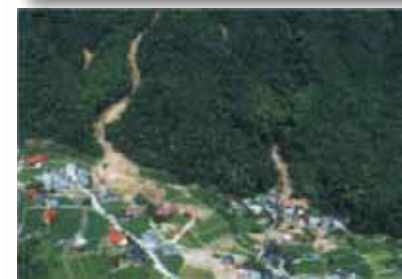
◀大毛寺川左支川(広島市安佐北区)土石流等により死者4人、全壊家屋3戸、半壊家屋1戸
