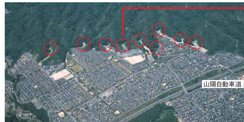
○ 砂防えん堤整備箇所
