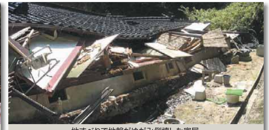
地すべりで地盤がゆがみ倒壊した家屋 H17.9 広島市佐伯区
