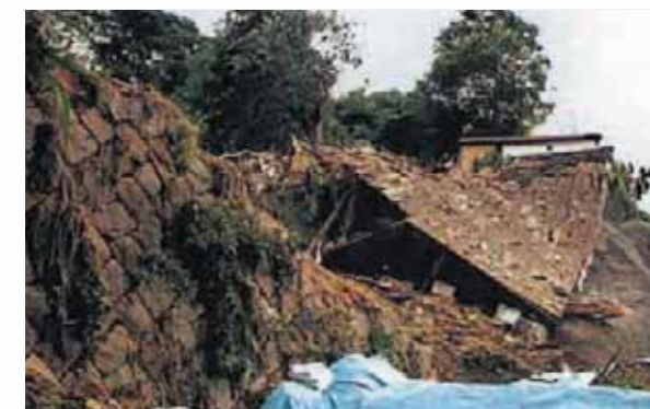
がけ崩れで倒壊した家屋 H11.6 呉市
