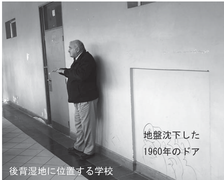
図 14 1960年バルデビア地震で地盤沈下した学校
