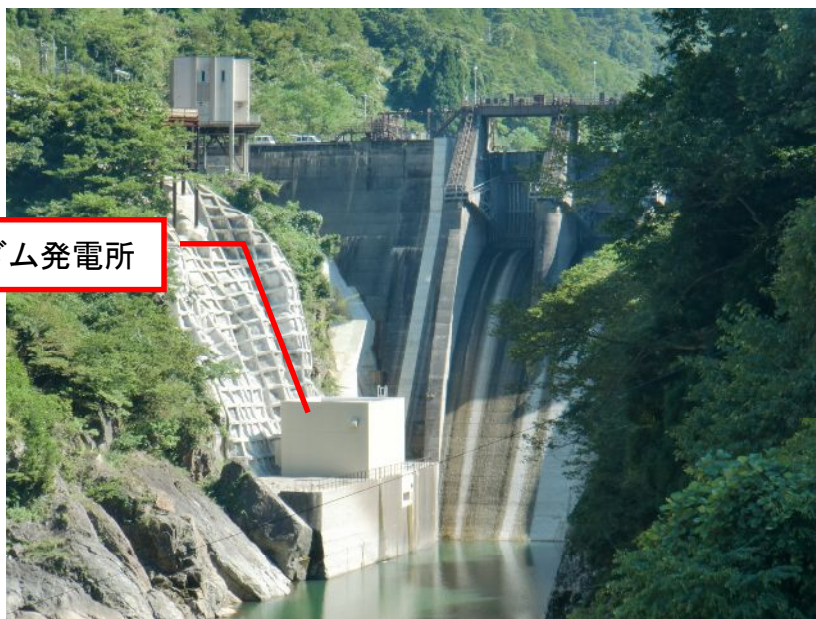
新猪谷ダム発電所外観
