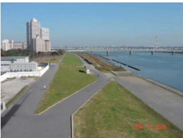
写真-6 広々とした高規格堤防上の空間
