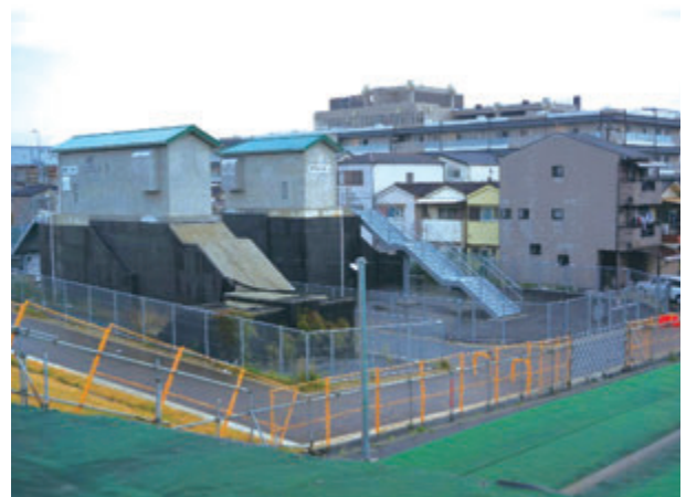
写真-7 大和川高規格堤防整備：高速道路の避難出口が先に立ち上がっている
