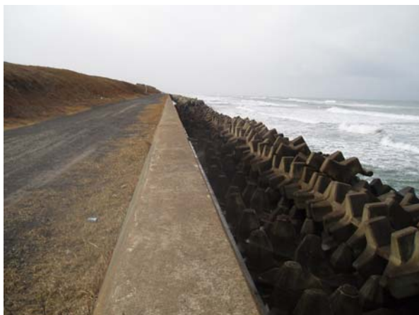
写真2 直立護岸と消波ブロック。内側は保守管理道路。海岸植生の存在場所はない。
