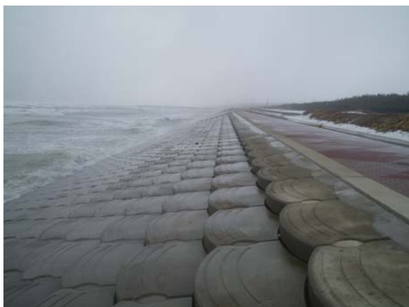
写真3 緩傾斜護岸。美観は向上したが植生の存在場所がないのは直立護岸に同じ。
