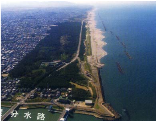
写真6 有明浜～上新栄町浜にかけて復活した砂浜。沖合い設置の離岸堤の効果。
