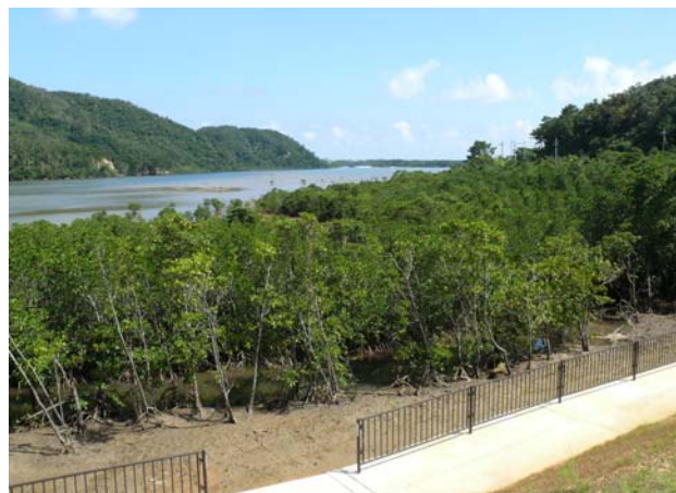
写真2 浦内川河口のコンクリート護岸とそれに伴って一部が伐採されたマングローブ林
