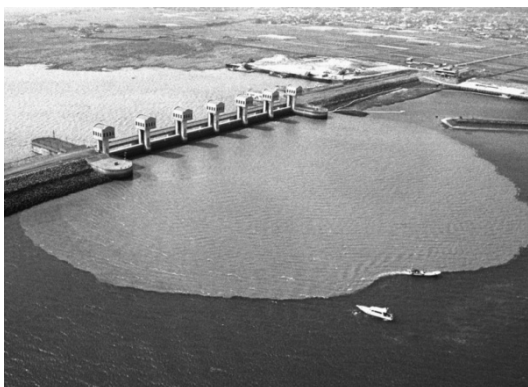
北部水門からの排水
