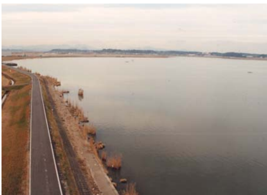
コンクリート護岸化された霞ヶ浦の岸辺
