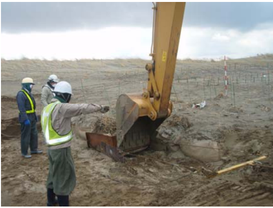
写真 7 既存植生を根こそぎ掘り取り予定地に移植したところ。周りの麻布は移植済みのもの
