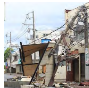
<飛来物による電柱倒壊の事例>
