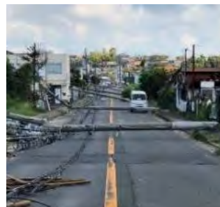
<電柱の倒壊による道路閉塞の事例>
