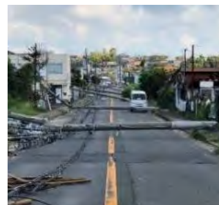
<電柱の倒壊による道路閉塞の事例>
