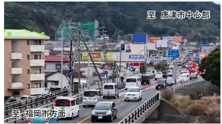
【写真①】渋滞のボトルネックとなる橋梁部
