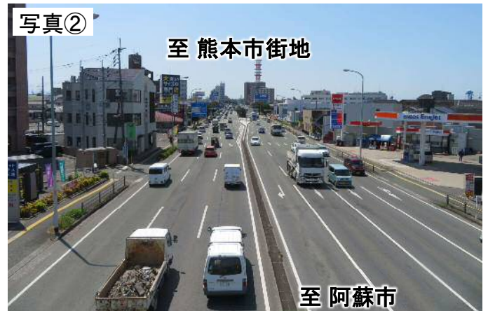
▲ 国道57号熊本東バイパス(6車線開通済)
