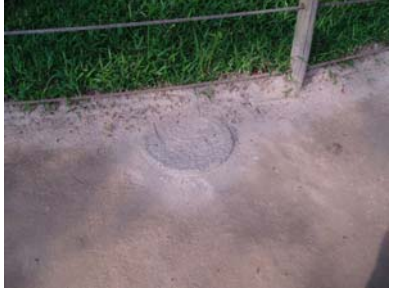
【写真1.5.29】カ 駐杖榻北西 台石 (原位置)
