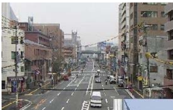
電線類の地中化 (施工前)
