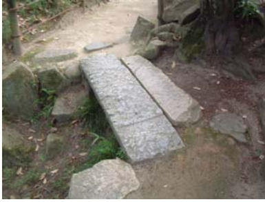
【写真1.5.61】菊澗橋 ○ 指定外区域の橋梁
