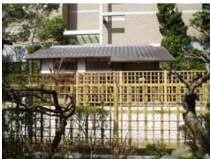
【写真2.2.9】女性用 便所 (東から)
