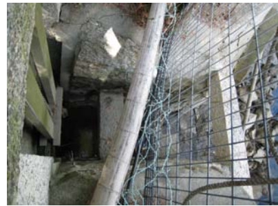
【写真 1.2.12】京橋川側水門導水路
