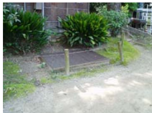
【写真2.3.16】銀河溪 ポンプ室外形
