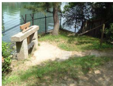
【写真1.2.11】京橋川側水門 (西から)
