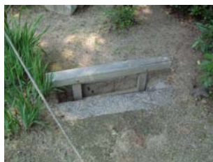
【写真2. 4. 23】龍門峡旧水門
