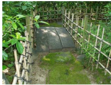
【写真1.5.68】薬草園南枯谷 無名橋
