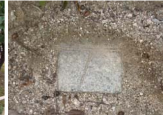
【写真2.4.8】旧境界標 (幟町中学校北)
