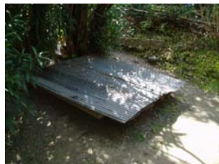
【写真2.3.17】桜花巷 ポンプ室外形
