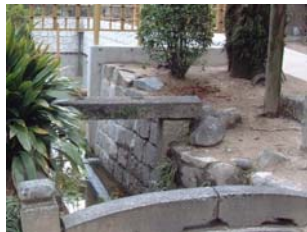
【写真2. 4. 22】流川旧水門
