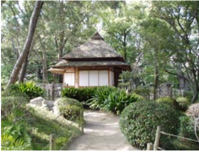
【写真1.6.4】明月亭(南面)
