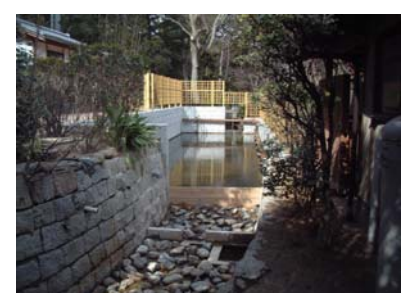
【写真 1. 2. 21】流川 間知石成 層積護岸
