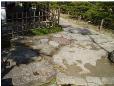
【写真1. 5. 38】跨虹橋南詰 (飛石・タタキ)
