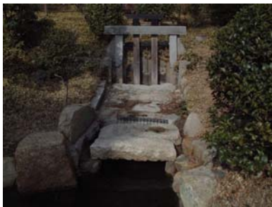
【写真1.2.10】濯纓池側水門 (南から)
