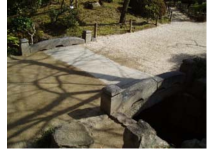
【写真1.5.63】流川下流無名橋
