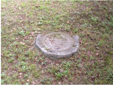
【写真1.5.28】オ 悠々亭北東旧台 石 (台石をモルタルで固める)
