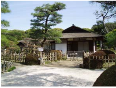
【写真1.6.1】清風館(玄関付近)
