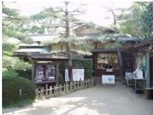
【写真2. 3. 1】事務所棟
