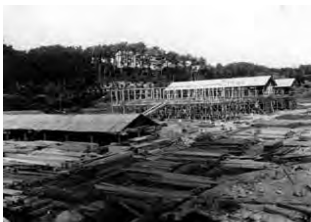
建設の進む駒越校舎群 昭和18年(1943)
