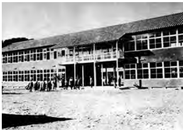
駒越校舎本館(1943年10月31日竣工)
