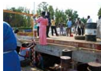
手作り量水標の設置及び測量 (P.15)
