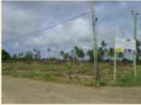
メガソーラー設置現場（起工前）
