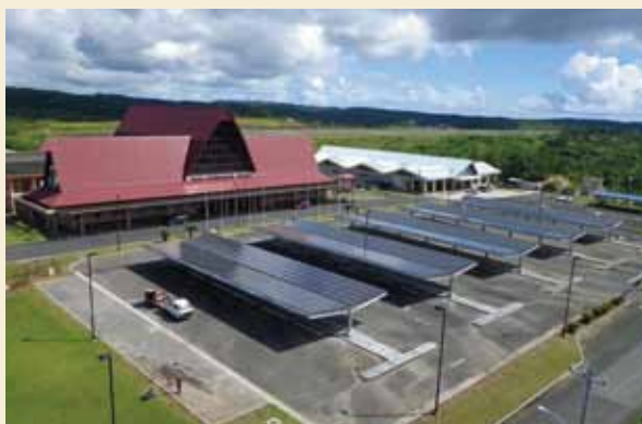
パラオ国際空港駐車場の太陽光発電
