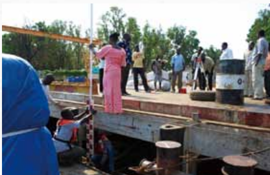
手作り量水標の設置及び測量
