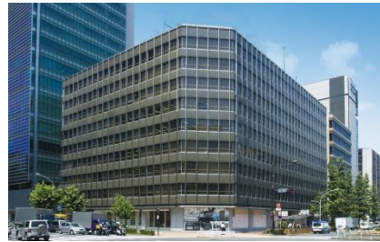
▲解体前の「(旧)日鐵日本橋ビル」
