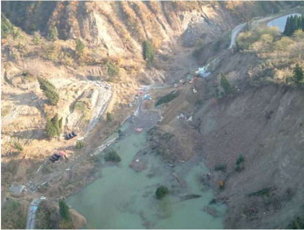
排水ポンプで水位を下げながら表面排水路工(プレスト管)を施工中
