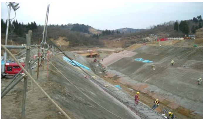
仮排水路施工状況(下流より上流を望む)
