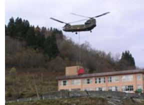
発電発電機(約6,000kg)運搬状況
