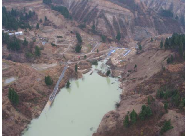
排水ポンプで水位を下げながら仮排水路を施工中
