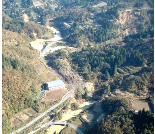
地すべり直後の状況
