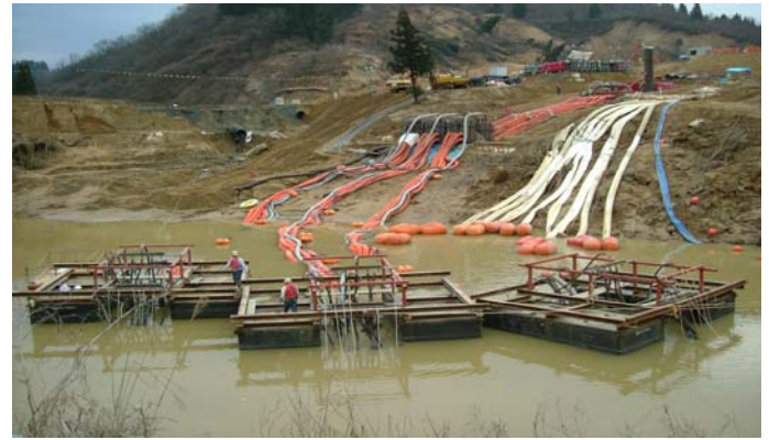
排水ポンプによる排水状況(15台稼働中)
