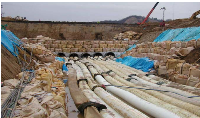
仮設排水管(呑口部)ポンプによる排水状況
