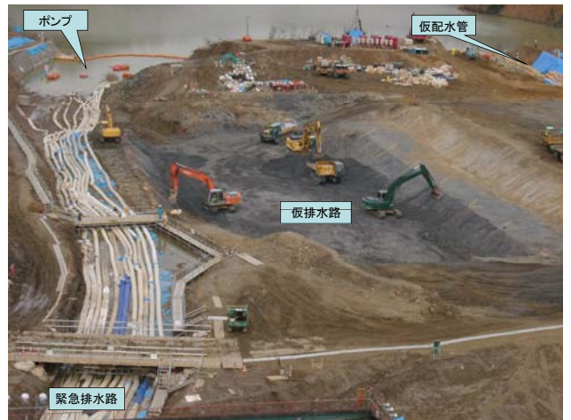
H16.12.4 東竹沢 仮排水路開削
