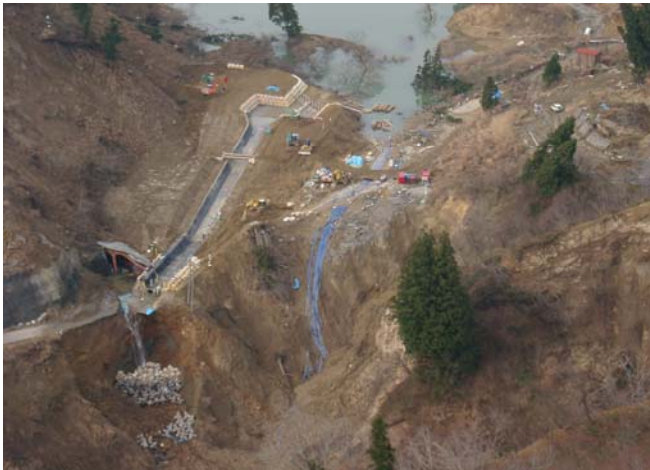
排水ポンプで水位を下げながら表面排水路工(開水路)を施工中
