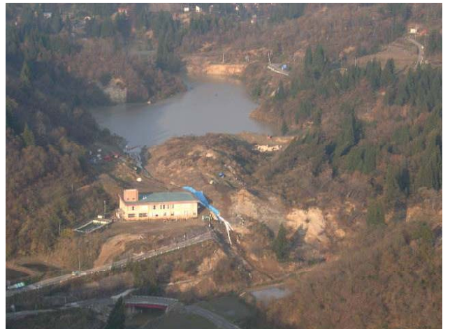
緊急排水路、排水ポンプ6台設置済み、越流防止工を施工中
