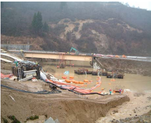
水位低下により新宇賀字橋が露出
