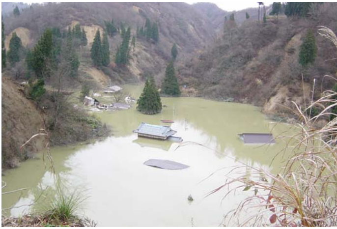
H16. 11. 29 木籠地区家屋浸水状況
