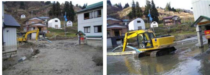
檜木集落の堆積土砂掘削状況
