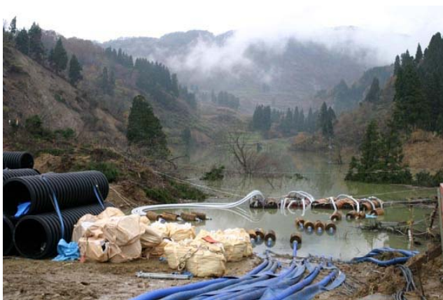
水中ポンプを最大で16台導入し、毎秒最大0.53m 3 の排水を昼夜を通して行いました。11月12日撮影
