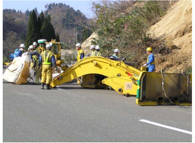
H16.11.9 分解してヘリ輸送した重機の組み立て
