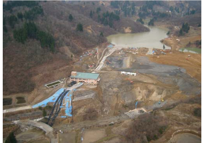
排水ポンプを12台に増設、で水位を下げながら表面排水路工(開水路)を施工中
