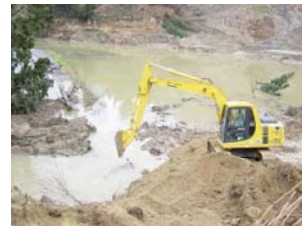
11月29日撮影 檜木河道閉塞箇所 の開削状況
