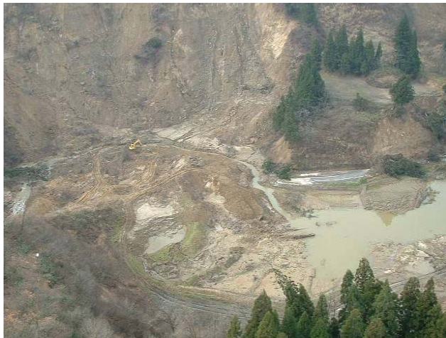
河道閉塞箇所開削状況
