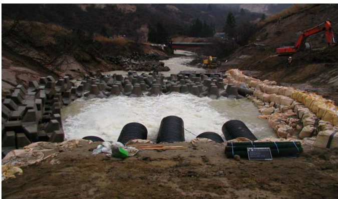
仮設排水管(吐口部)ポンプによる排水状況
