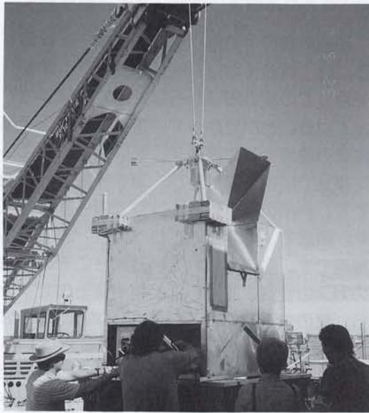
(図2) 我々の望遠鏡。この箱の中に、望遠鏡や検出器が入っている。ひさしの下のフタをあけて、そこから星をのぞくしかけ。
