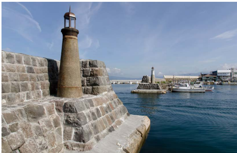
廣井の哲学を尊重して修復された船入澗防波堤
