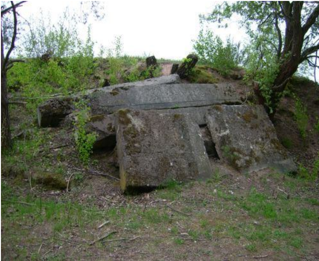
Diese Betonrümmmer stammen wahrscheinlich noch aus Zeiten der Nutzung des Platzes durch die Deutschen
