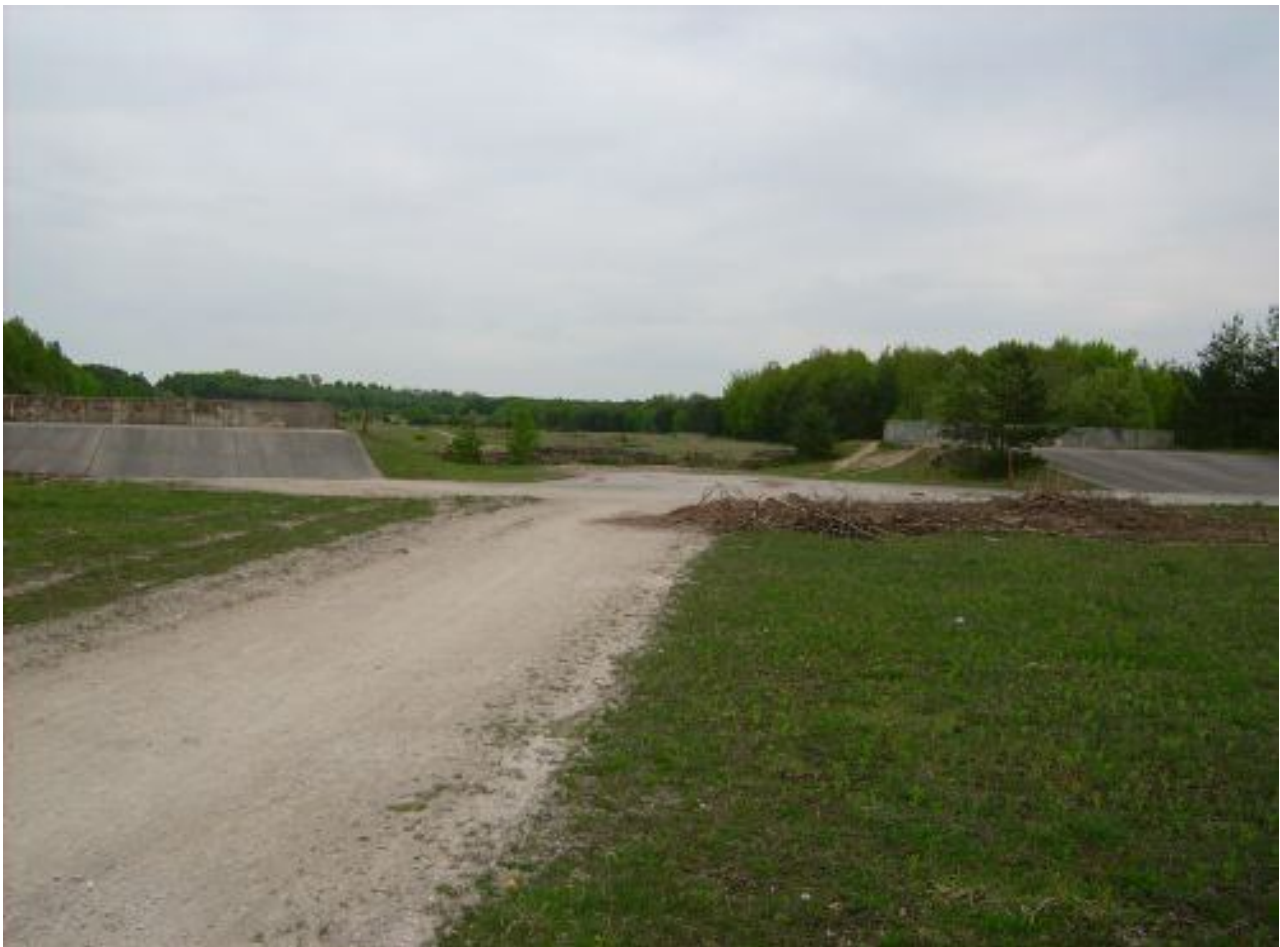
Zwei betonierte Rampen für Panzer auf der Range 6 von diesen Positionen aus bekämpften Panzerbesatzungen
