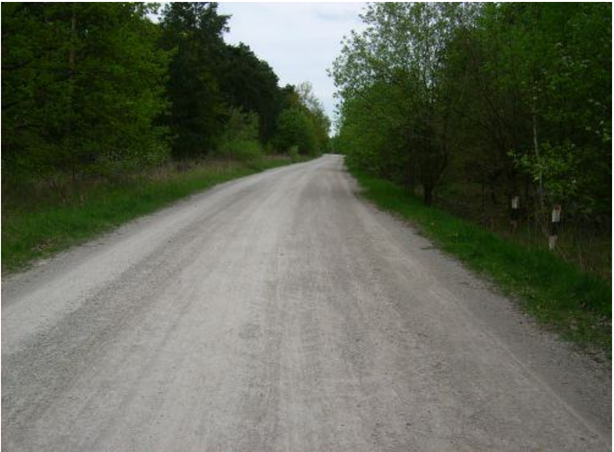
Panzerstraße im Naturschutzgebiet Tennenloher Forst. Das Gebiet ist von gut ausgebauten Straßen durchzogen
