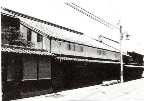
写真1. 室内を改造した町家の外観
