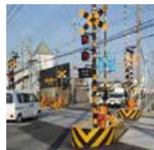
踏切改良工事
