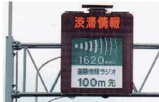
写真 8-2-7 路側放送の案内標識
