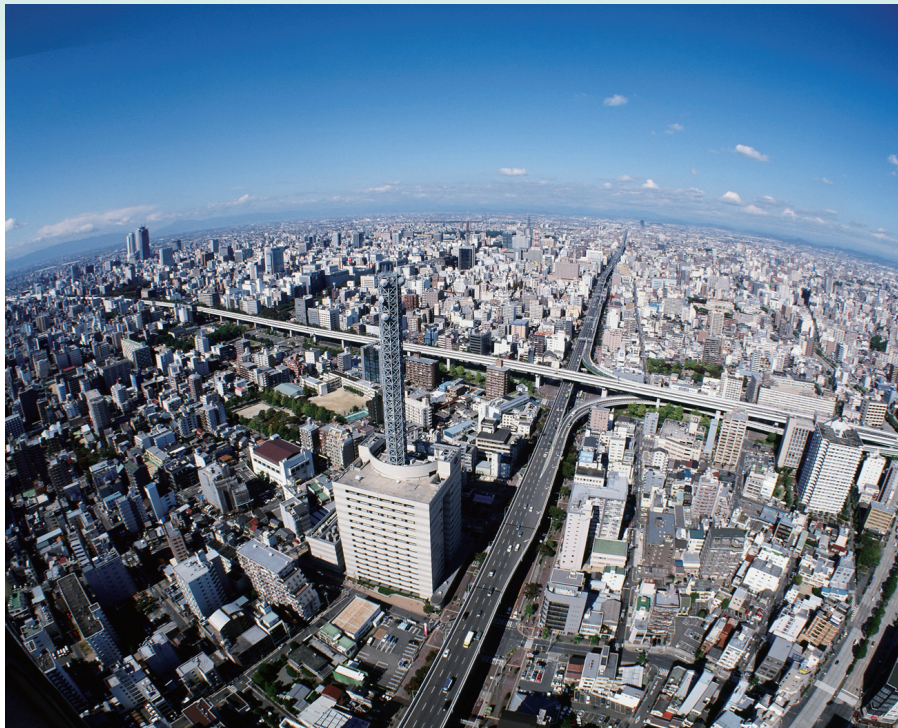
丸田町 JCT ~ 鶴舞南 JCT 合流・織込み交通区間
