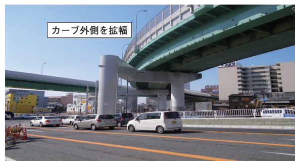
写真-2 くの字梁橋脚
