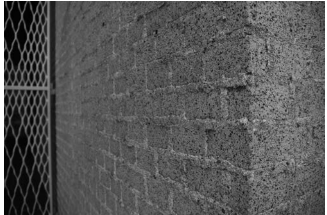
【写真8】村野・森建築事務所 1階外壁タイル
