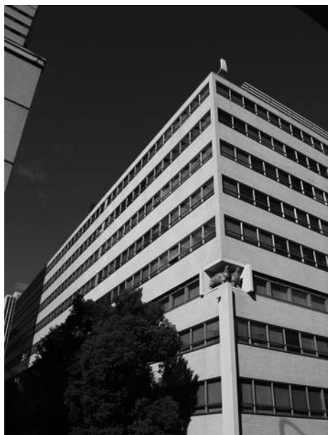
【写真1】新ダイビル 外観 第1期（手前）と増築部の第2期（奥）
