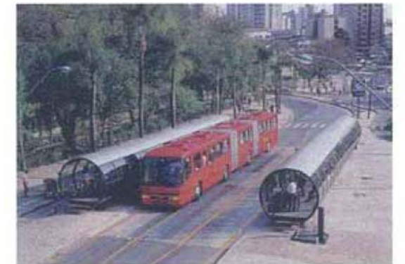
▲クリチバ市(ブラジル)のチューブバス停 (バス車体の床高さまでかさ上げしたバス停で、改札口があり運賃収受も改札内に入る時に行われる)
